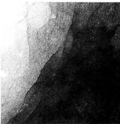
图5 节理化岩体顶板冒落
